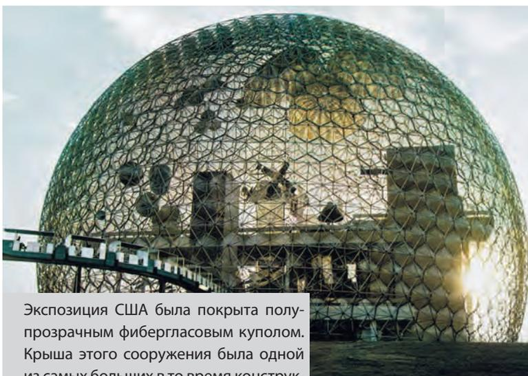
Экспозиция США была покрыта полупрозрачным фиброгласовым куполом. Крыша этого сооружения была одной из самых больших в то время конструкций подобного рода.
