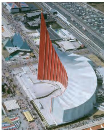
Павильон СССР был построен в форме развернутого знамени площадью 20 тыс. кв. м и высотой 109 м. Его ступечатая конструкция была облицована по бокам тонкими, окрашенными в красный цвет стальными листами, а крыша была белого цвета. Помимо экспозиционного пространства в планировке здания были предусмотрены концертный и кинозалы на 800 и 600 мест соответственно, а также кафе и бар.
